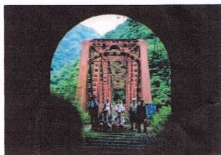
隧道(トンネル)につづく鉄橋を渡る
