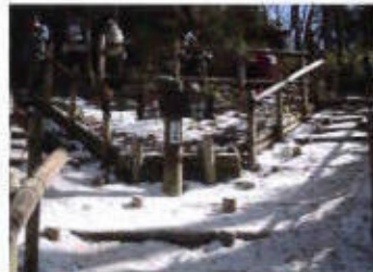
(圧雪がある8合目付近)
